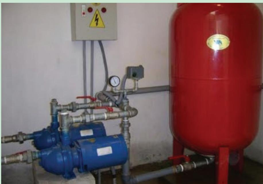
Foto 11. Sistema hidroneumático.
