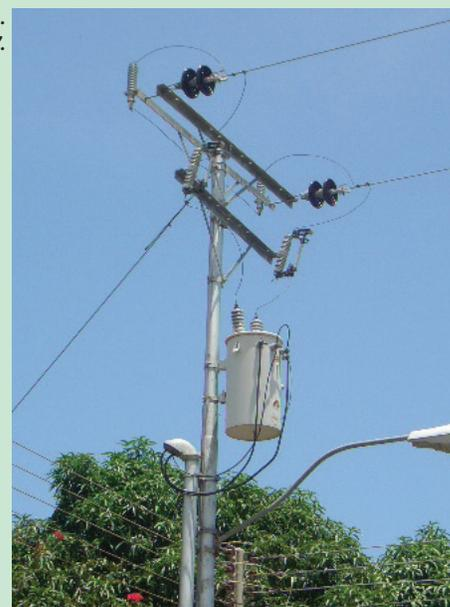
Foto 7. Transformador eléctrico.
