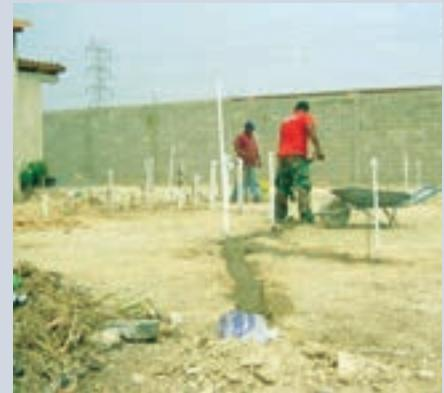
Luego se continúa con la excavación para embutir el sistema para recolección de aguas de lluvia posteriormente revestido con un mortero a base de una (1) parte de cemento y cuatro (4) de arena. Para este sistema se usó tubería de diámetro  $\varnothing 4$ " del tipo PAVCO®.
