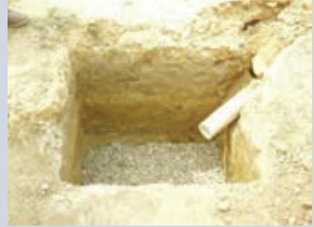
Se continúa con el replanteo y colocación de las tuberías para el sistema de electricidad ubicado por debajo de la losa de fundación. Los tubos para el sistema de fuerza e iluminación son de diámetro  $\varnothing \frac{3}{4}$ " y los correspondientes a la acometida principal de diámetro  $\varnothing 1$ ".
