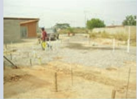
A continuación se hacen los encofrados en los laterales de la base de pavimento.
