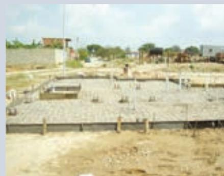
Se continúa con el proceso de vaciado de concreto de la losa de pavimento con concreto premezclado de resistencia a la compresión de  $250 \text{ kgf/cm}^2$  (proporción 1 : 1,5 : 2,5 como relación cemento/arena/grava) en varias fases:
