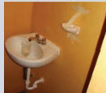
Las paredes de servicio se recubrieron con mortero a base de cal con acabado liso para posteriormente revestirla con pintura de caucho color oro dorado.
