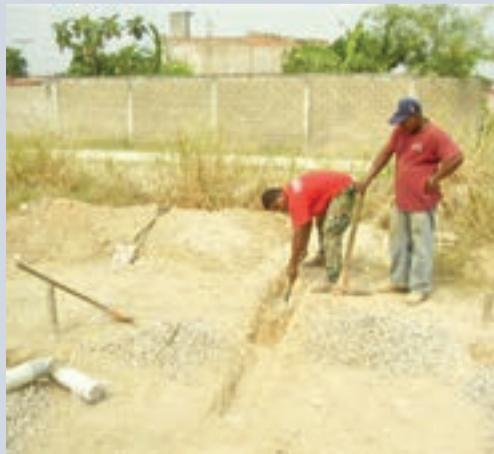
Se coloca la base de piedra picada n° 1 en el fondo de los elementos metálicos verticales y en toda la base de pavimento.
