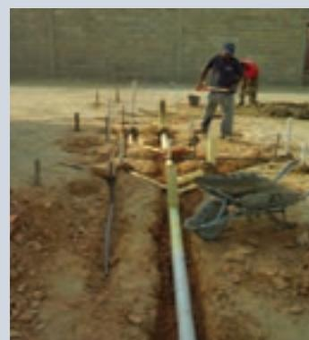
Posteriormente se realiza la excavación para la tanquilla de aguas servidas de dimensiones 60cm x 60cm x 60cm, se procede al empotramiento, la colocación de la base de piedra picada y por último a la construcción de la tanquilla con la conexión al cachimbo de la parcela.
