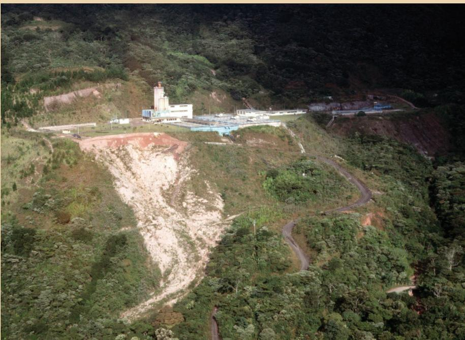
Colapso cosísmico del terraplén y de la vía de acceso construida sobre el talud del mismo en la planta de tratamiento de agua de San Rafael de Cordero al norte de San Cristóbal, estado Táchira, con motivo de un temblor local ocurrido el 4 de febrero de 1989 con una magnitud de solamente 4.3 (Fotografía André Singer)
