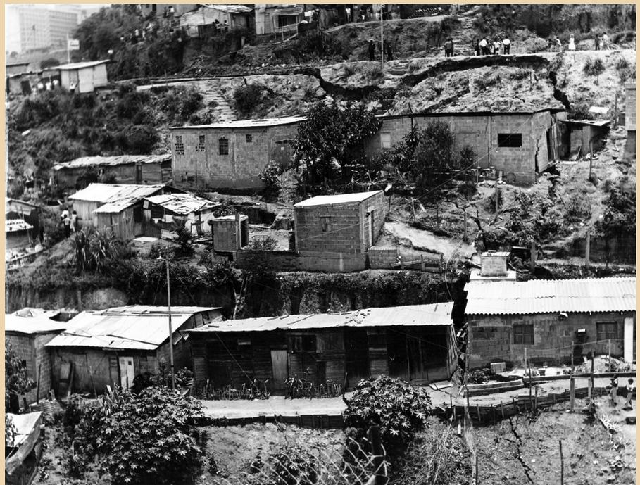
Deslizamiento cósmico de una ladera empinada ocupada por viviendas precarias en un barrio de Gramoven (entrada oeste de Caracas) al resultar impactada la misma por el terremoto de 1967. El área deslizada, que afecta tres niveles de viviendas, está claramente definida por una cicatriz de tracción con un trazado en doble arco, responsable además de la interrupción de la vía principal de acceso al barrio (Comisión del Terremoto de 1967, Fondo Documental, CEDI-Funvisis)
